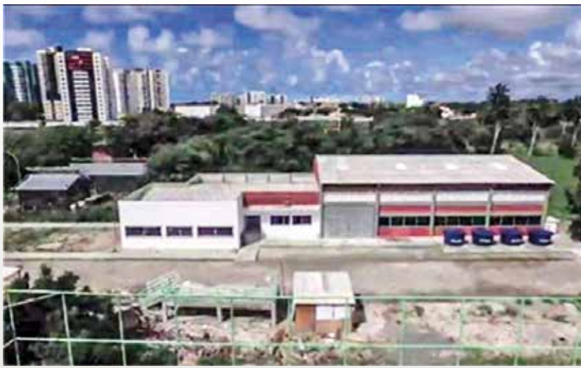
Foto 3 - Vista externa do LAPIMAR (em construção)
